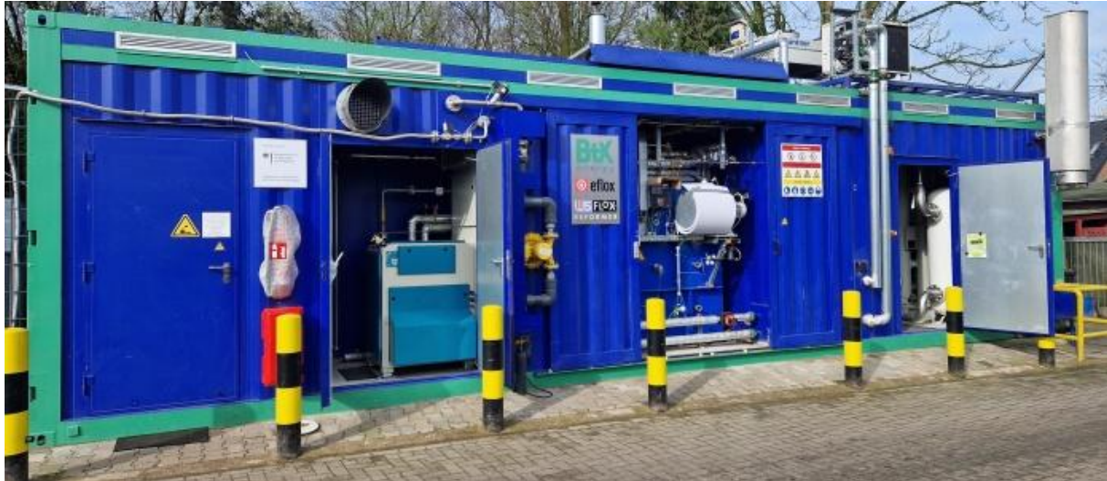
Bild 3: Demonstrationsanlage zur Erzeugung von 100 kg/Tag Bio-Wasserstoff.
