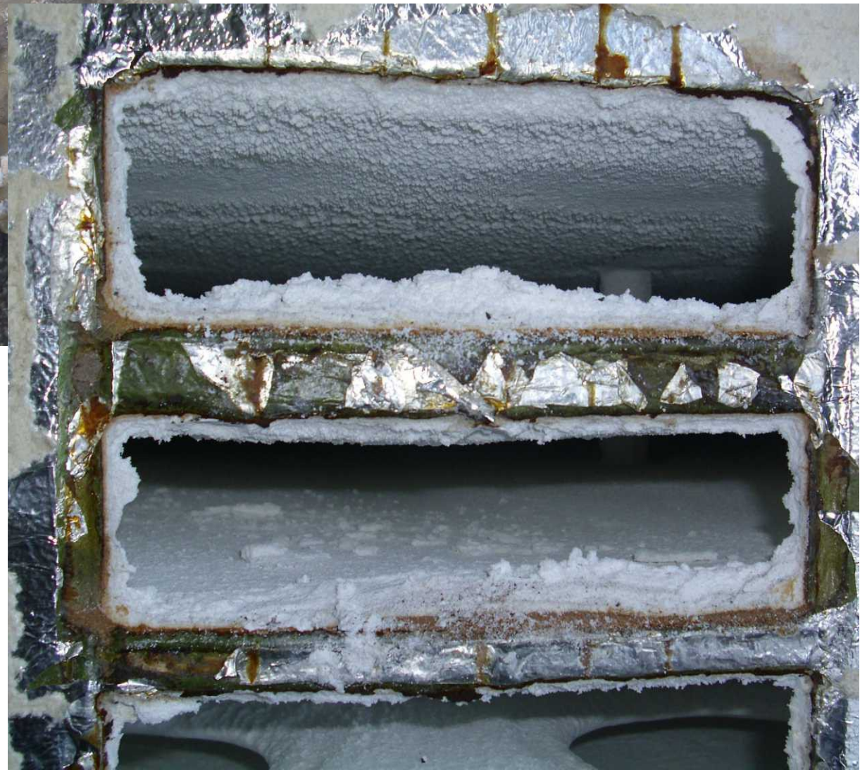
\text{SiO}_2 Staub in einem Abhitzekessel
